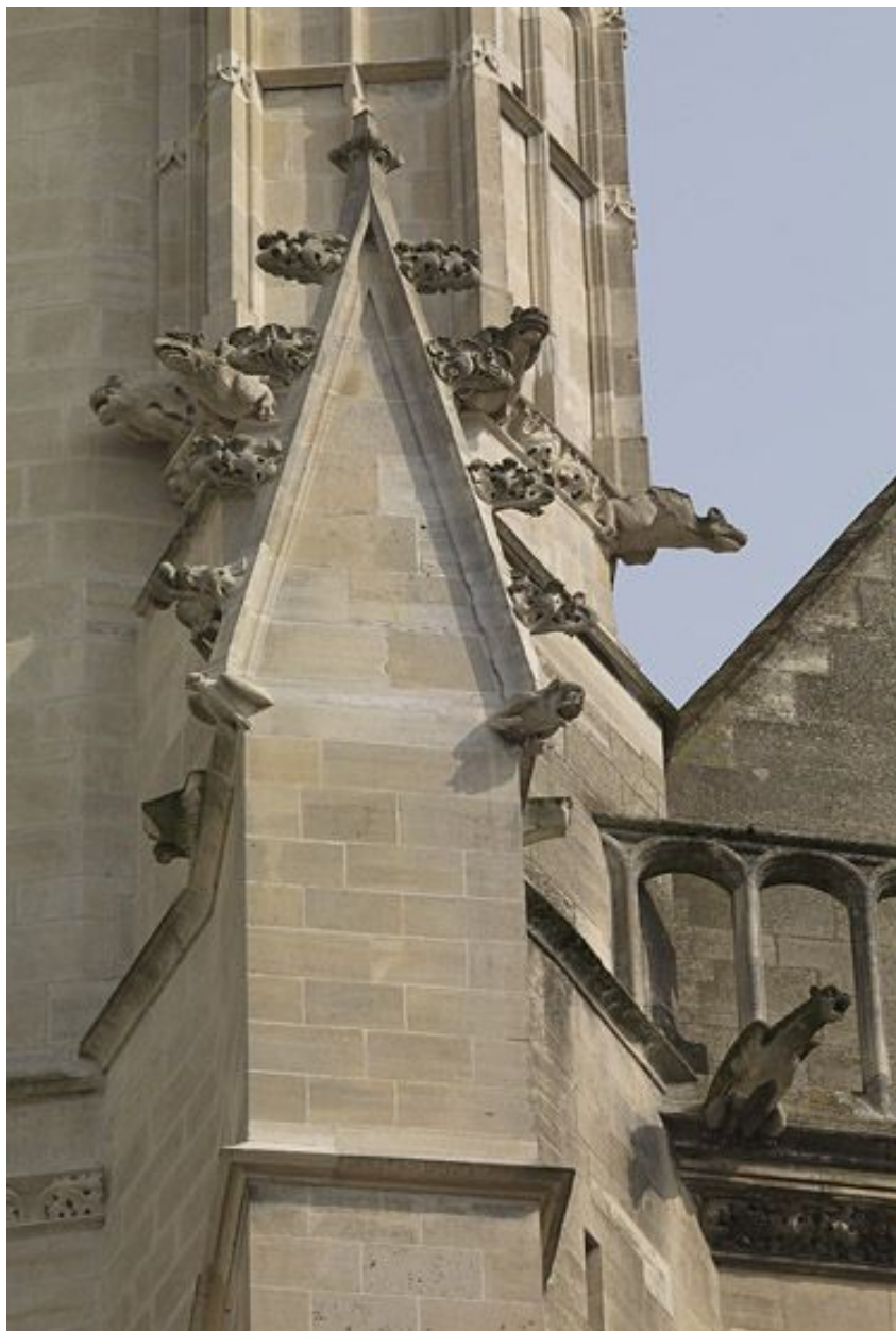
Détail de la façade occidentale : gâble couronnant le contrefort sud-ouest de la tour nord.
