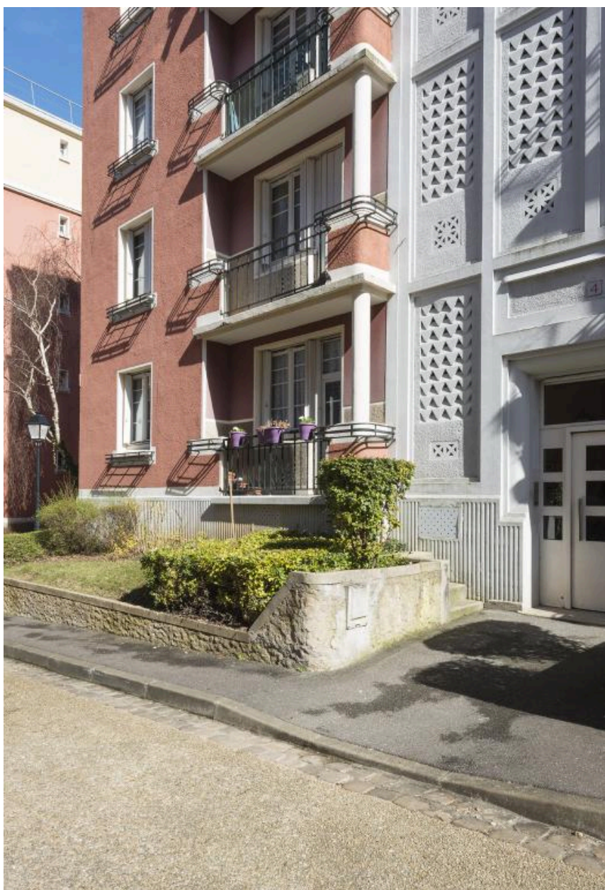
Façade du bâtiment latéral (2)
