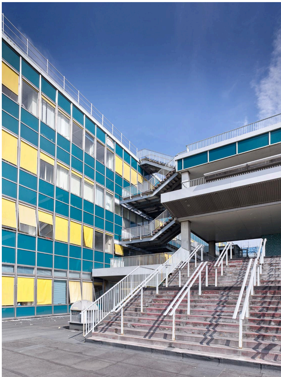
2018, terrasses, circulation verticale: escalier ouest, 4ème étage.
