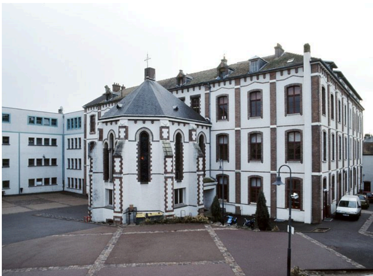
Le bâtiment principal : élévation nord, vue depuis le nord-ouest.
