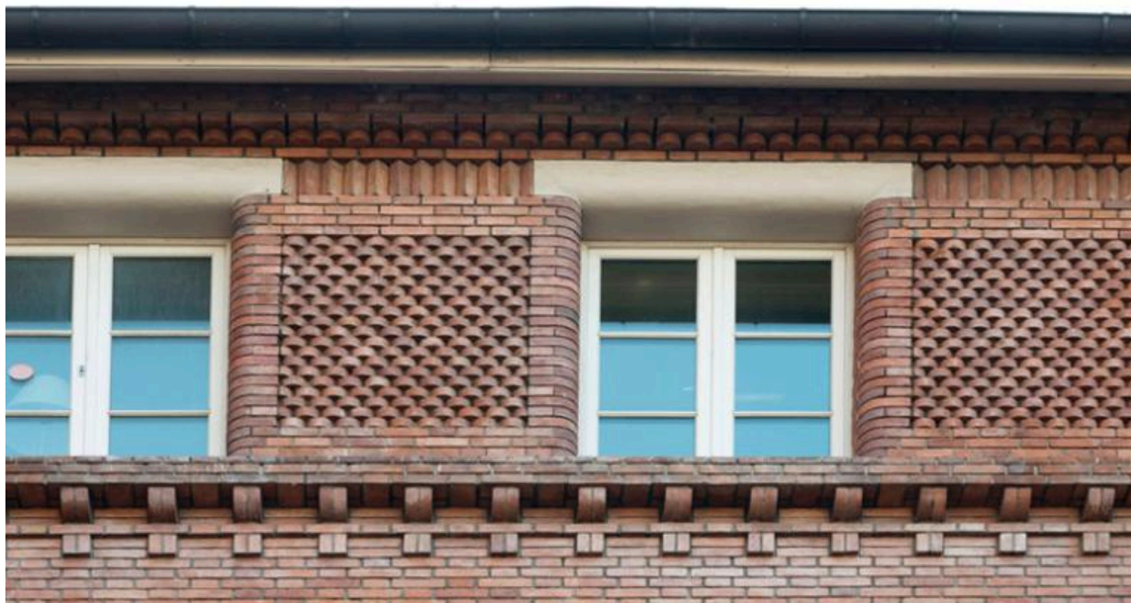
Détail des baies du dernier niveau et du calepinage de la brique.
