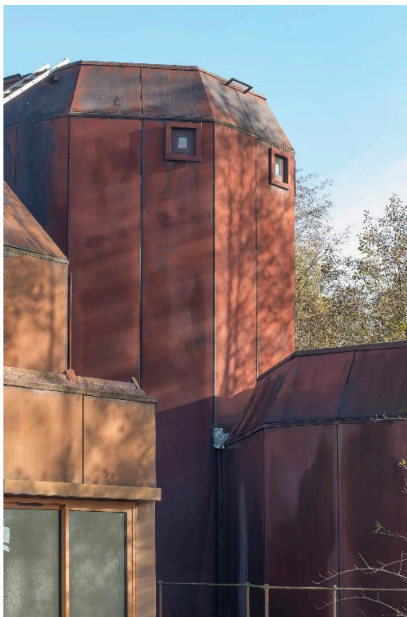
vue rapprochée du pavillon octogonal à l'extrémité de de la facade sud
