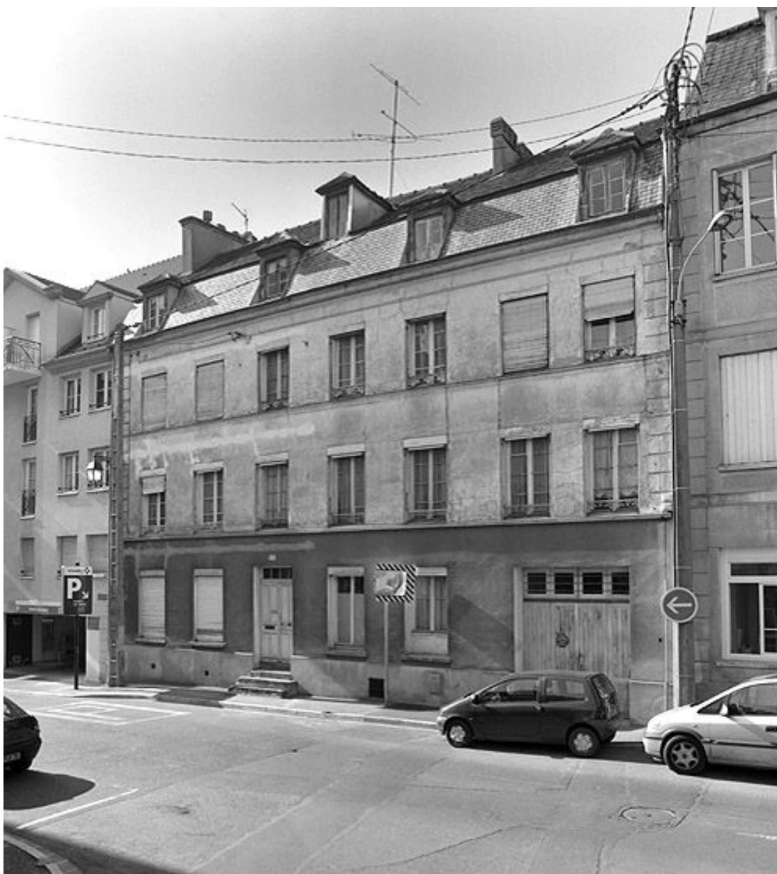
Vue d'ensemble, depuis la rue.
