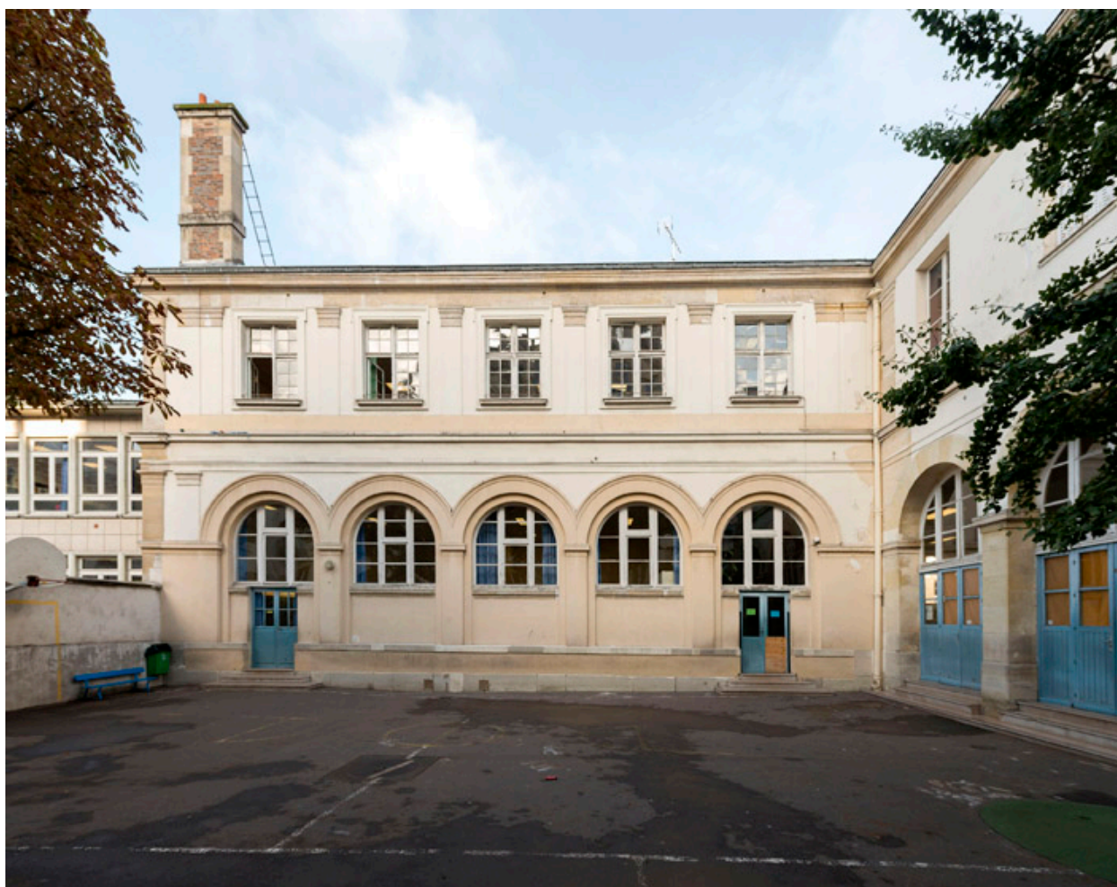
Vue du bâtiment abritant les salles de classe.
