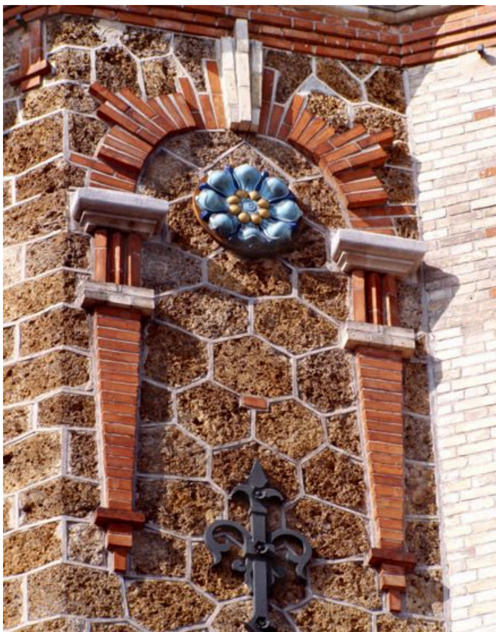
Immeuble, 17 rue Léopold Bellan. Détail de la mise en oeuvre des matériaux, meulière, brique et céramique vernissée. Thionnet (entrepreneur)
