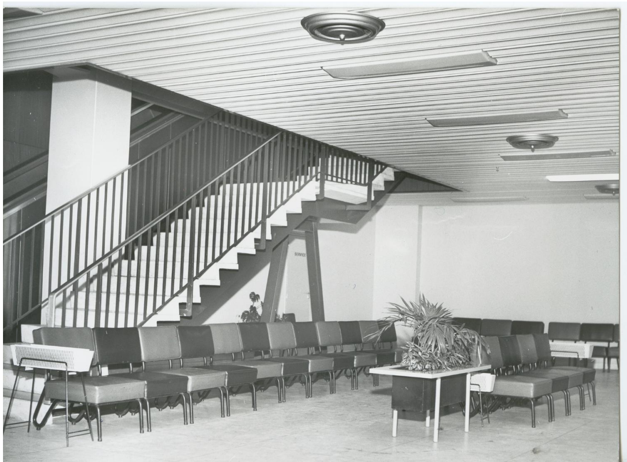
1961, salle d'embarquement, rez-de-chaussée coté piste.
