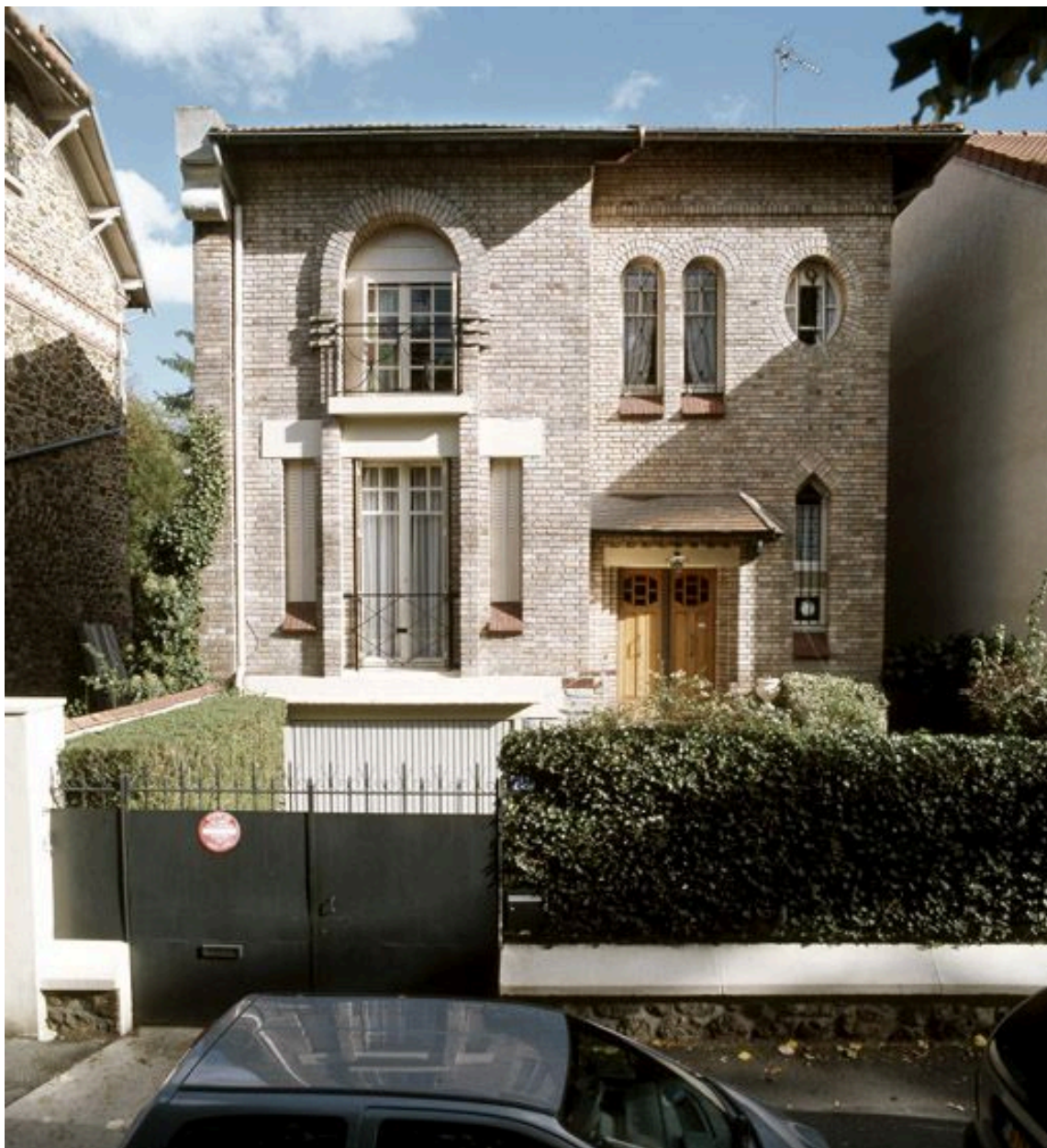
Maison, 72 rue de Coulmier. Vue d'ensemble.
