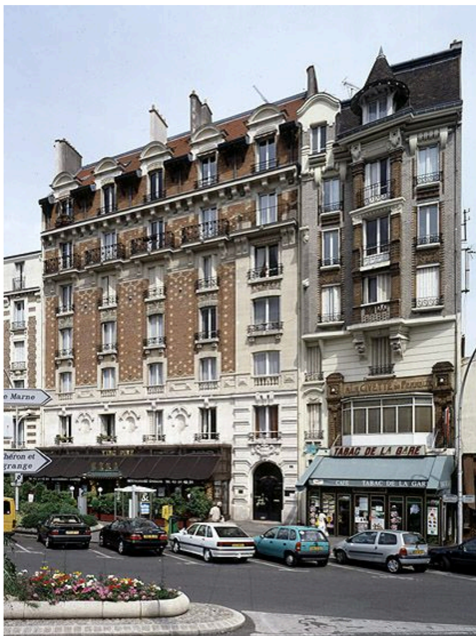
Immeubles, 6-8 place Robert Belvaux.
