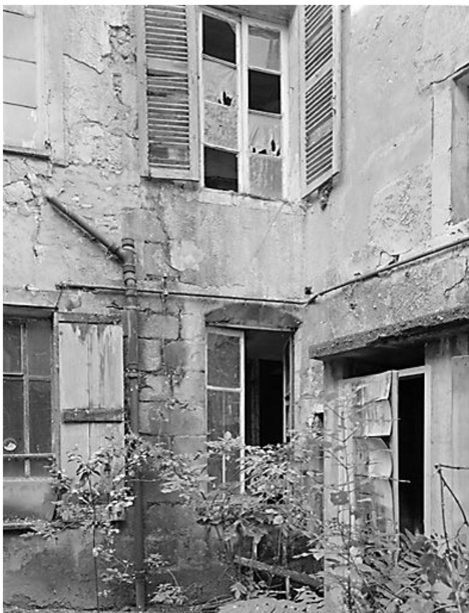
Corps de logis n°1 : détail de l'élévation latérale est.
