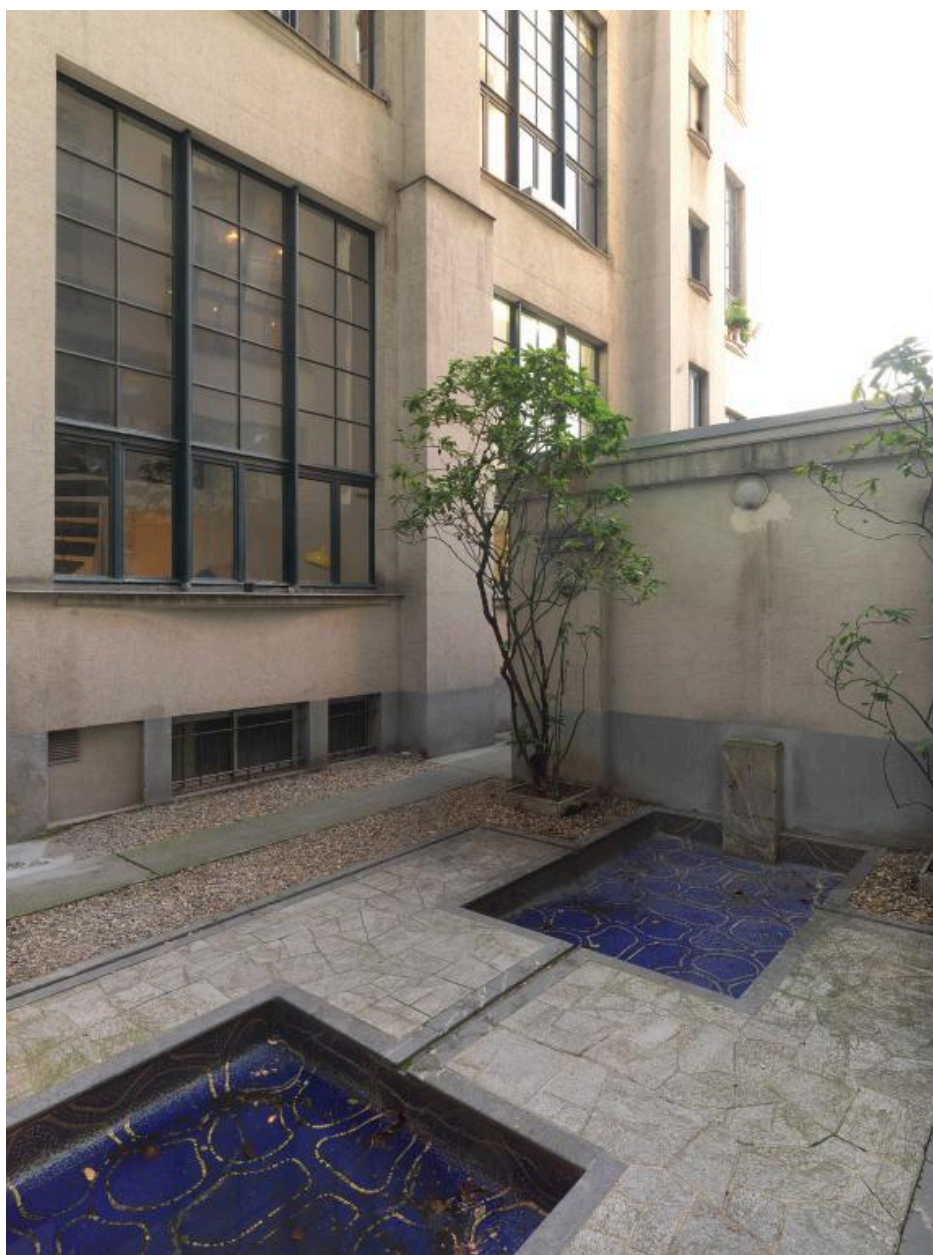
Vue de la cour et des bassins donnant sur la rue Victor Schoelcher
