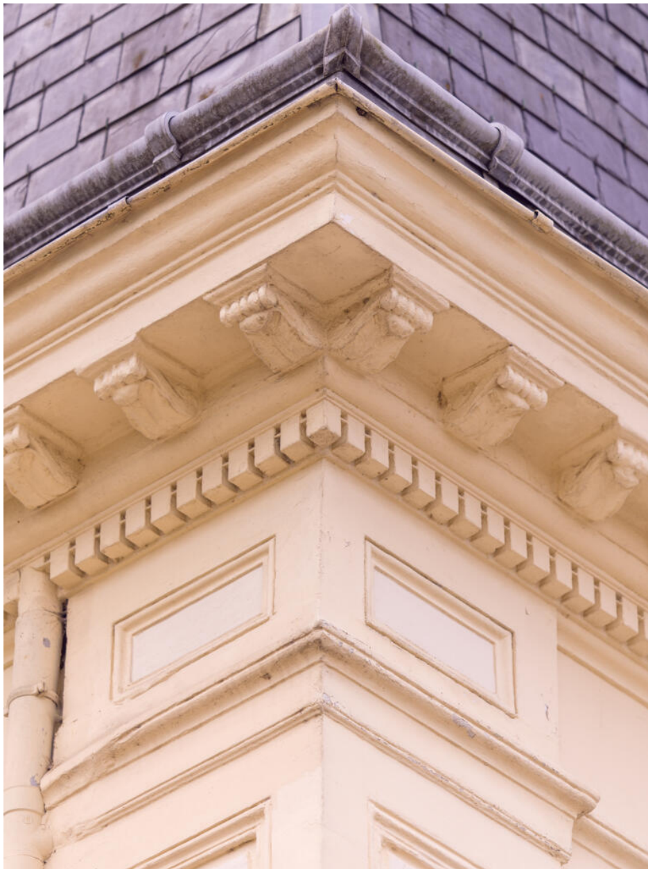
Vue du décor couronnant les façades.
