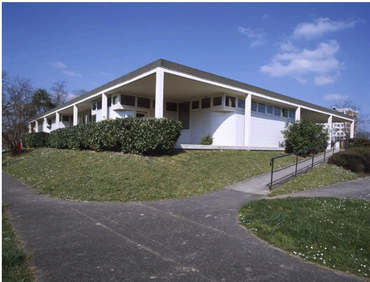
Façades latérale sud et postérieure.
