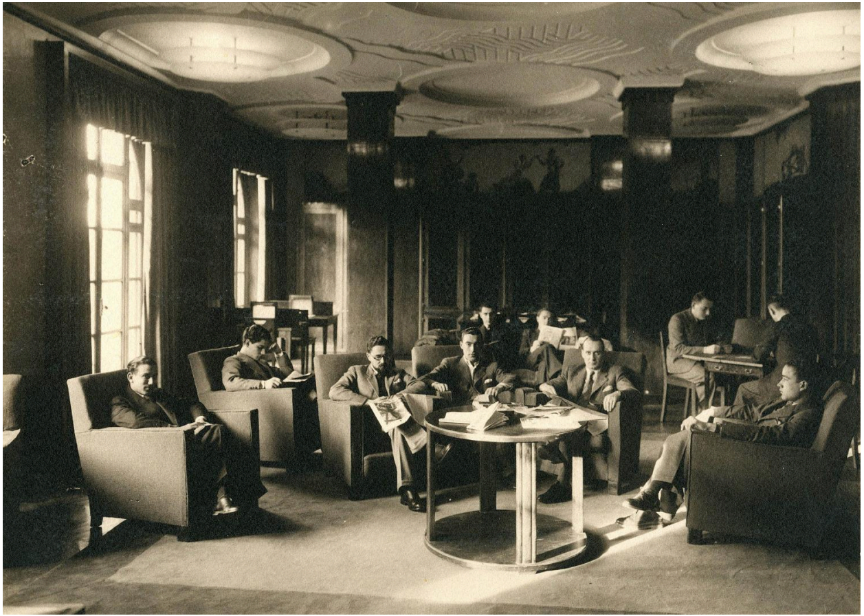
Vue du grand salon. 1938. CIUP, centre de valorisation du patrimoine, P/TP- A 2-PI 112.
