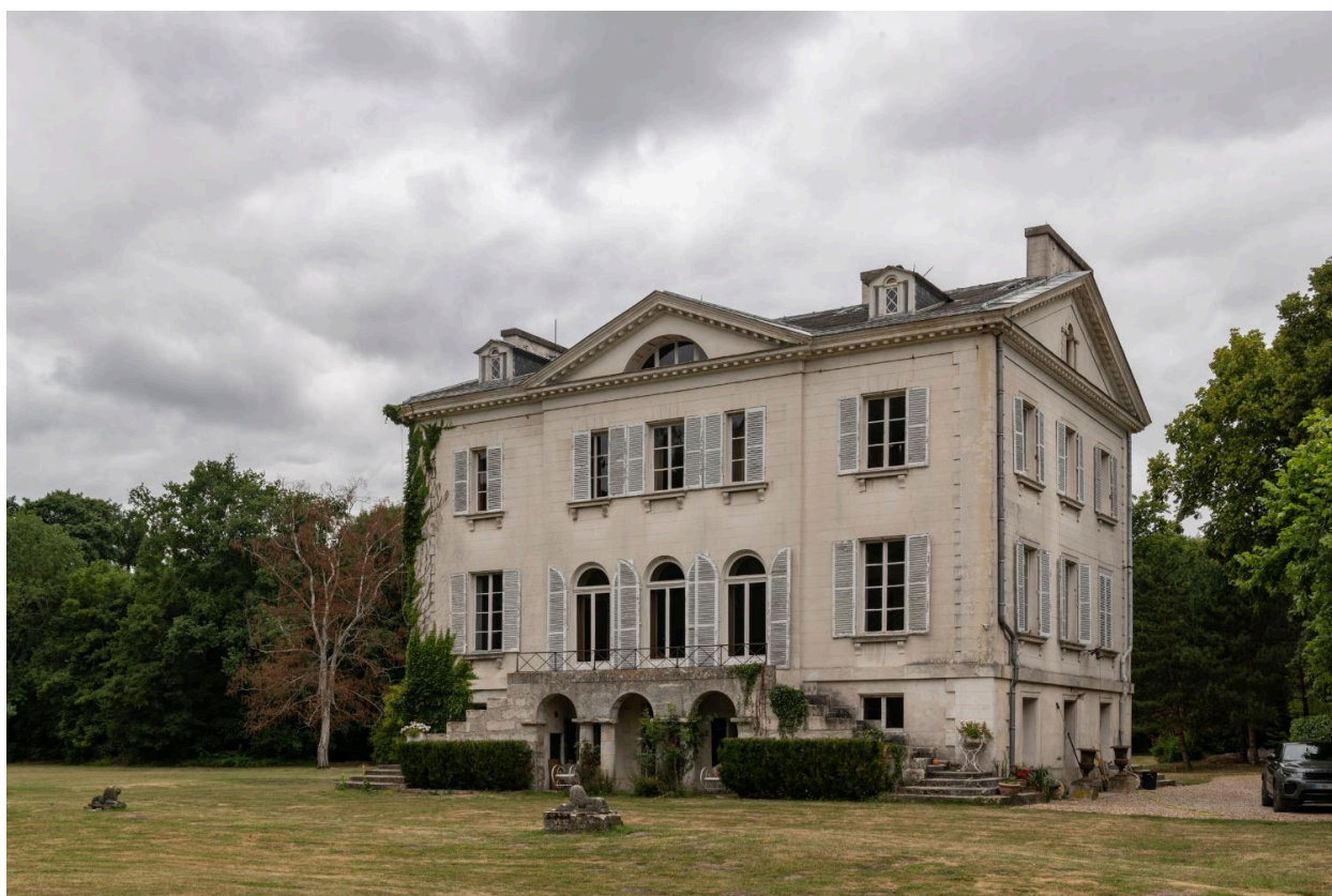
Façade postérieure et façade nord
