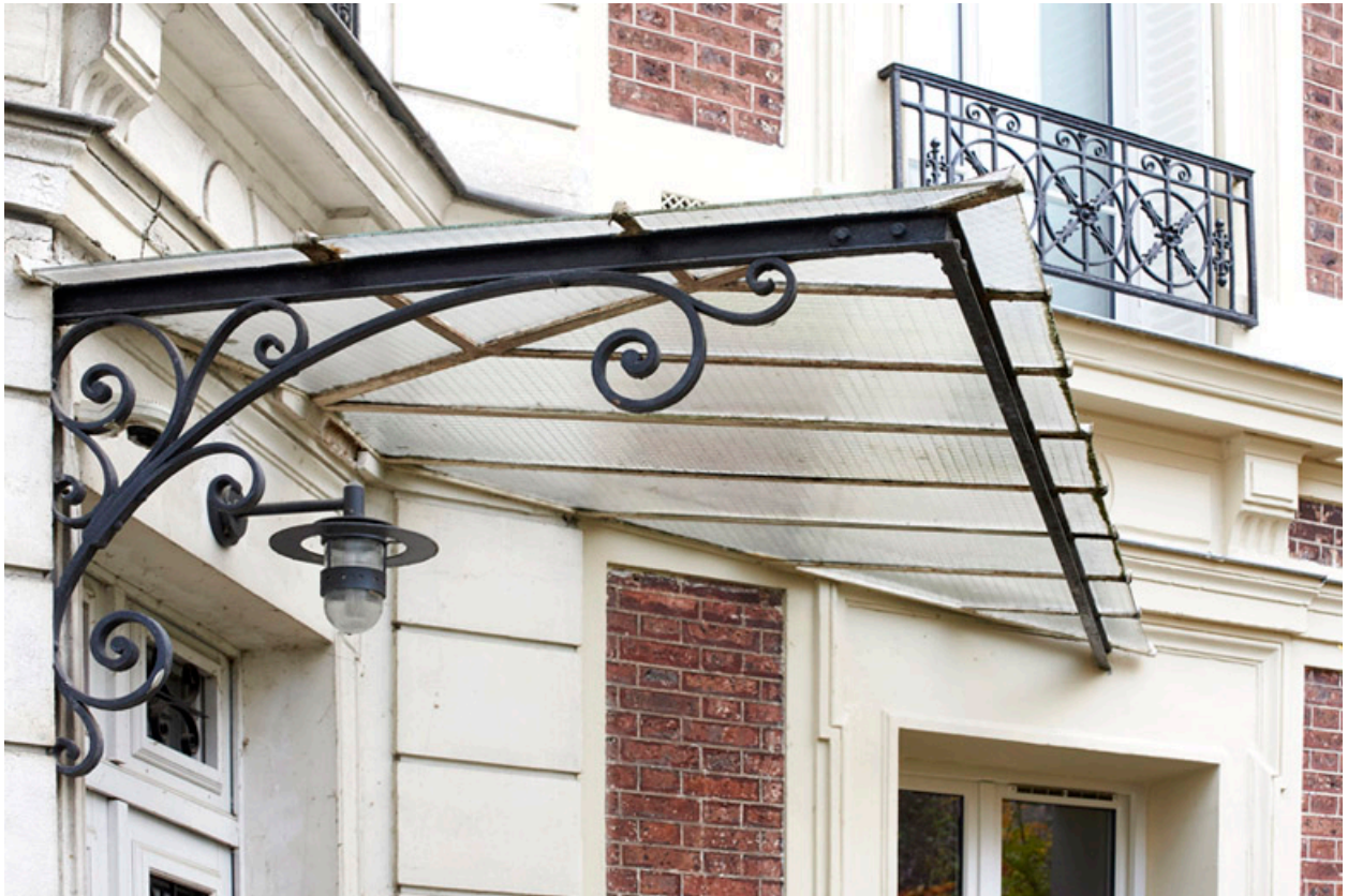
Vue de la marquise placée sur la façade latérale du pavillon à gauche de l'allée.
