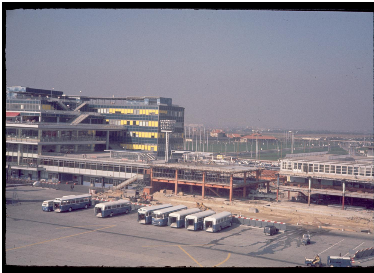
1961 février octobre, les travaux de jonction des Installations Terminales et de l'Aérogare-Sud, vus depuis le sud est.
