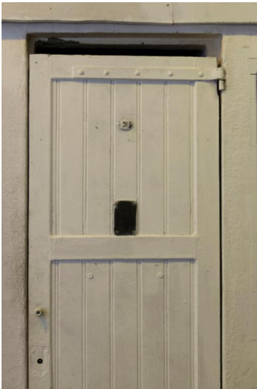
Porte en bois d'une cabine de douche.
