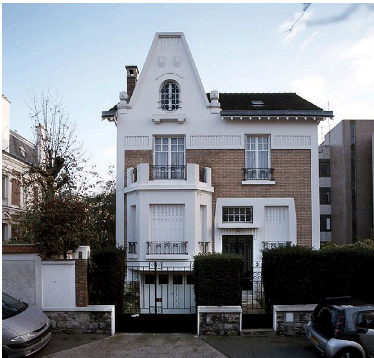
Maison, 2 rue Plisson. Vue d'ensemble.
