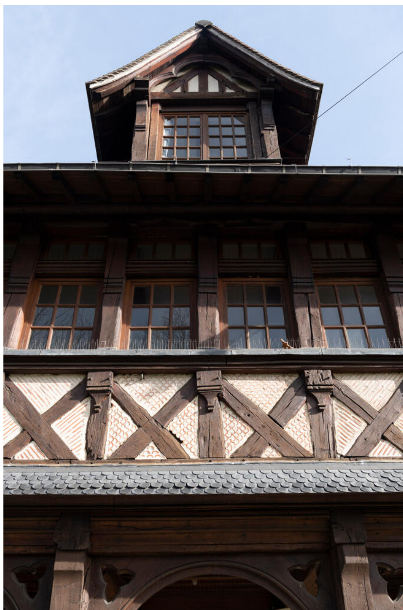
La façade de l'extension sud, ajoutée en 1893.
