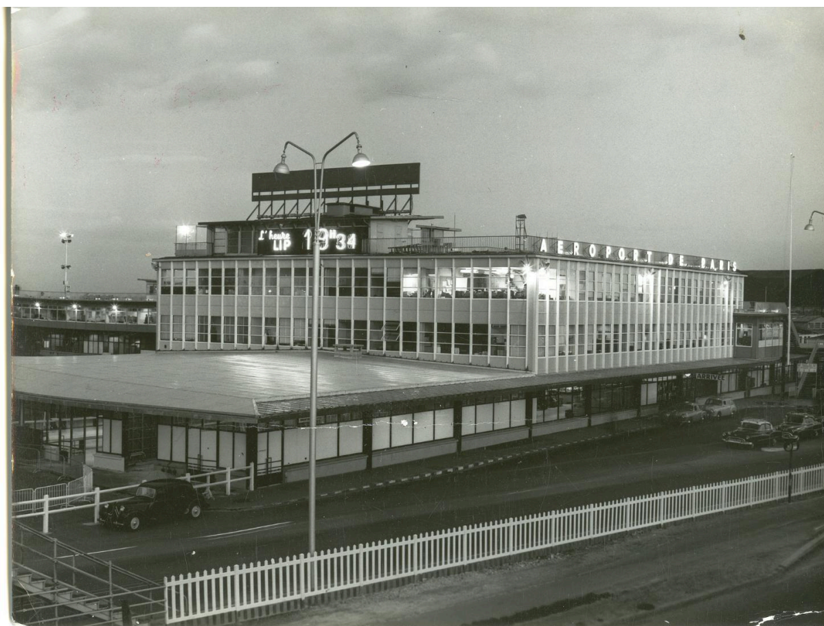
Après 1954 vue de l'Aérogare-Sud prise depuis la nationale 7 (nord ouest)
