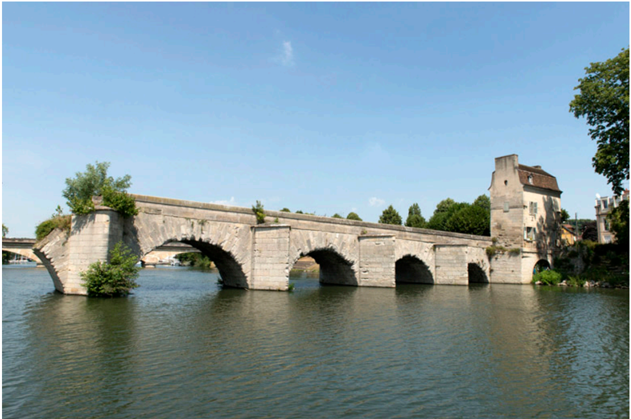
Vue des quatre arches du côté de Limay.
