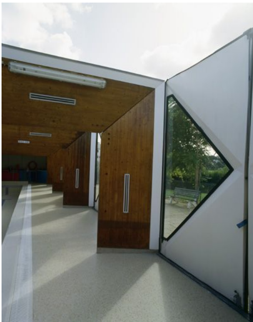
Vue intérieure : vue perspective du mur de façade.
