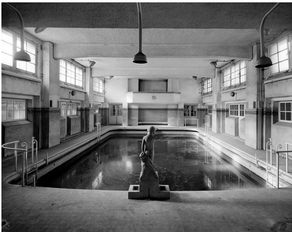
Piscine. Vue intérieure vers l'entrée et la tribune. Groupe scolaire, lycée dit école Maurice Payret-Dortail, puis lycée Paul Langevin
