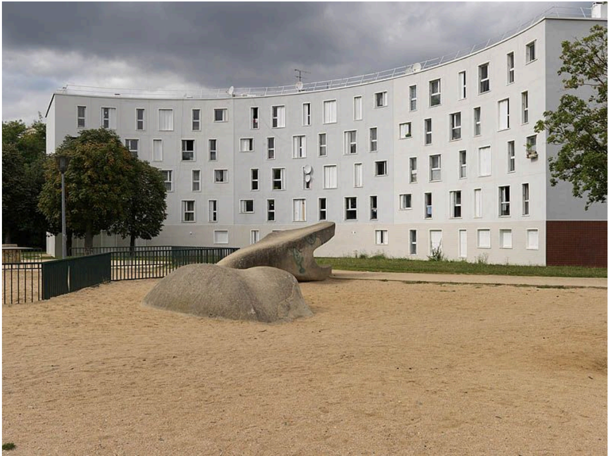
Quartier des Radras, vue de la place de l'étang avec une sculpture de serpent en béton.
