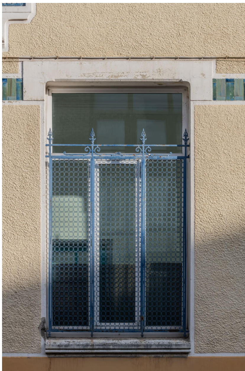
École des Coteaux, fenêtre du bâtiment de 1922
