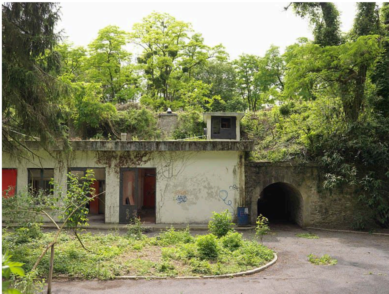
Vue des locaux techniques du CEA adossés à la partie extérieure de la batterie sud du fort.
