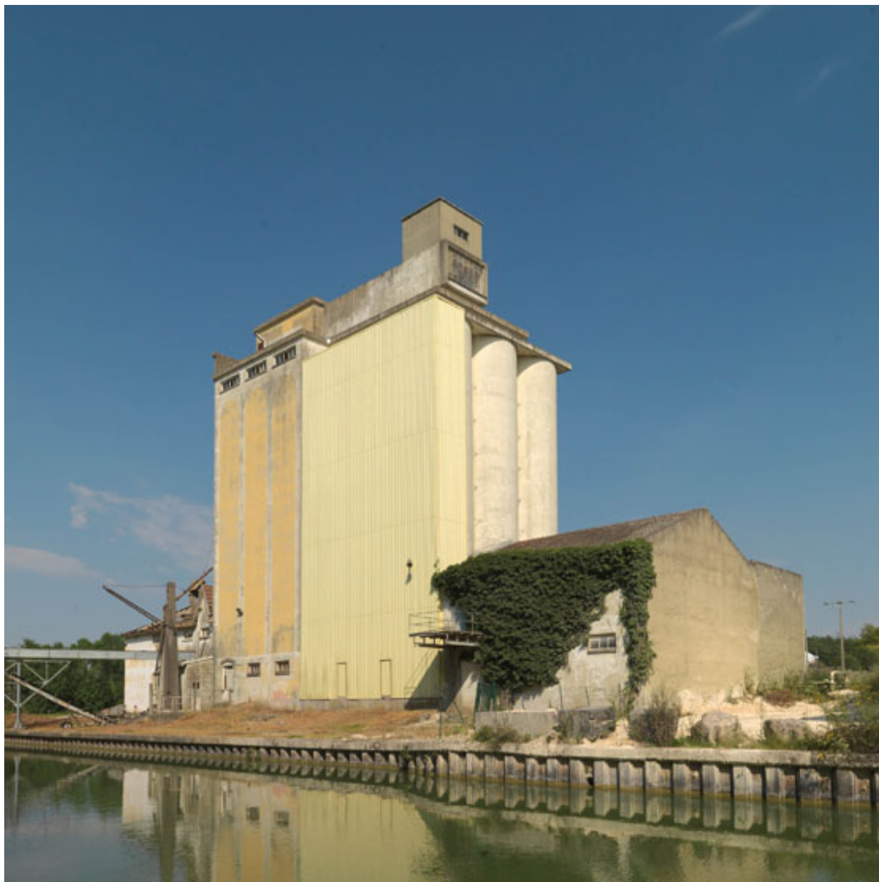
Silo vu du canal du Loing.
