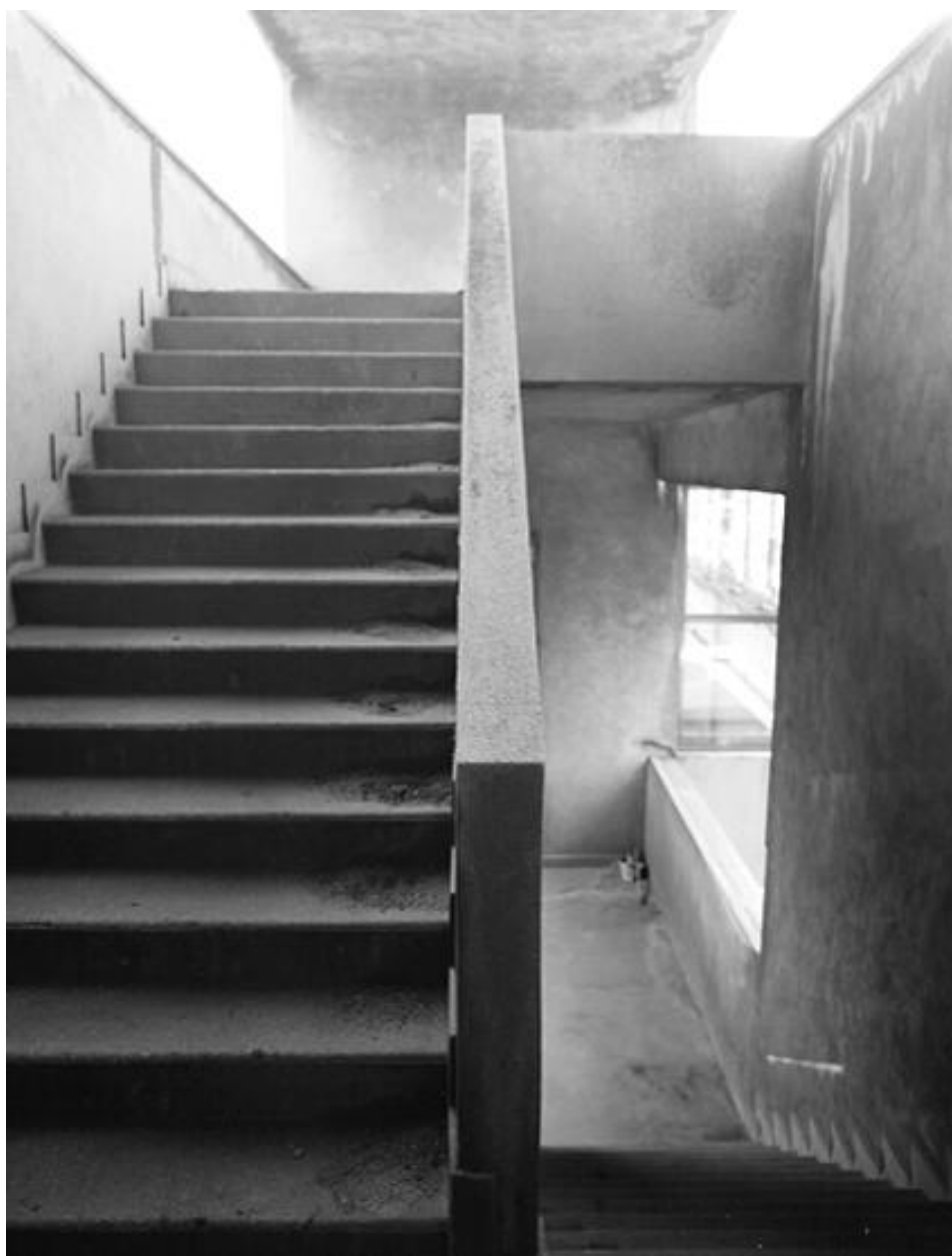
L'escalier d'accès à la tribune pris en direction du gymnase. Groupe scolaire dit groupe scolaire Karl-Marx
