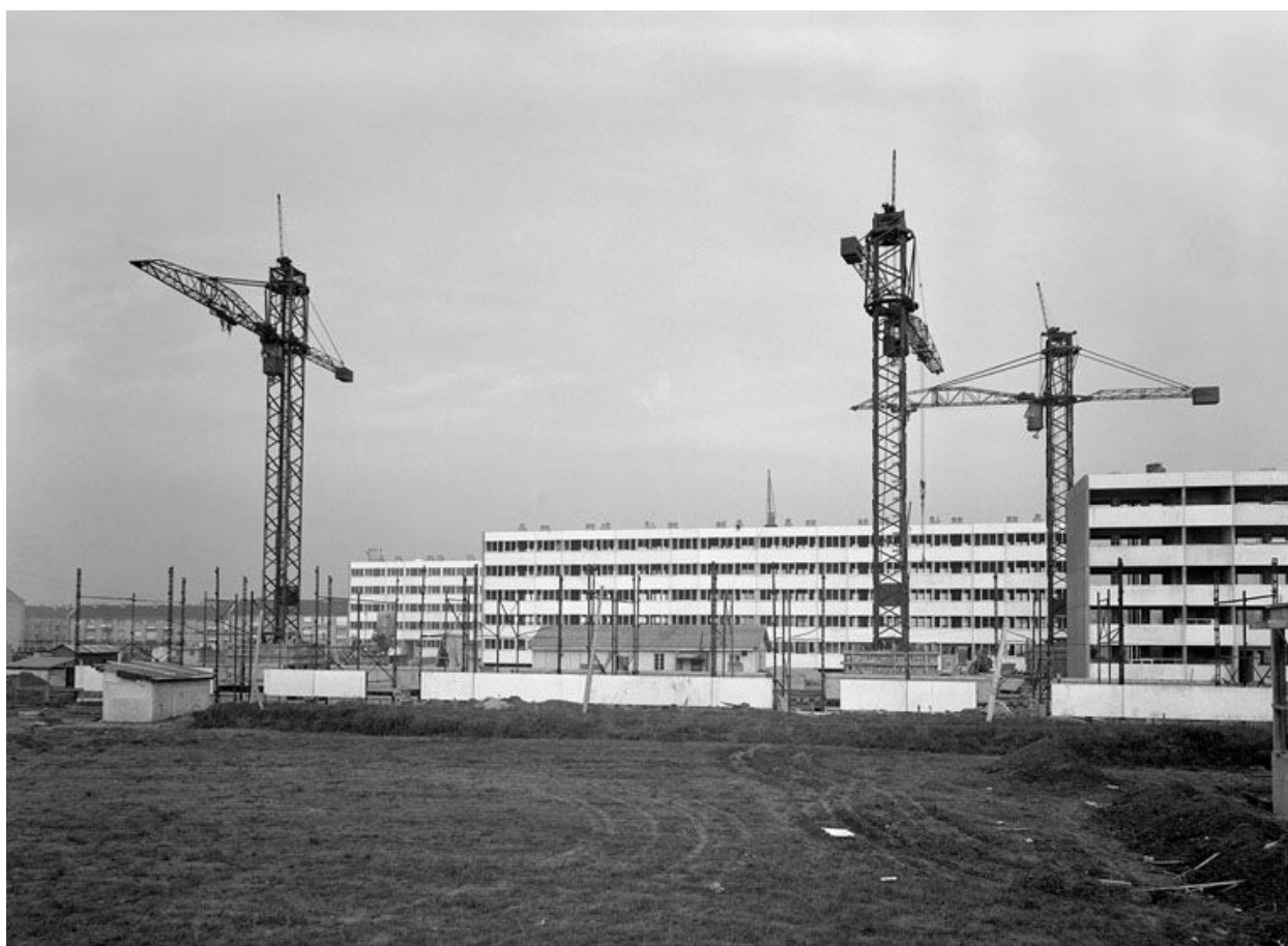
Vue du chantier de construction. Photographie, 1961. (Ministère de l'Ecologie, MRU 3677003)
