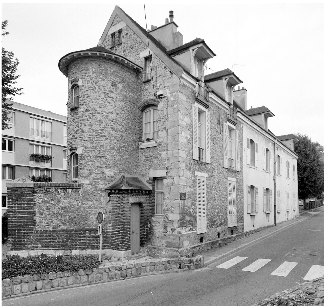
Vue du pignon et de la façade nord-est.
