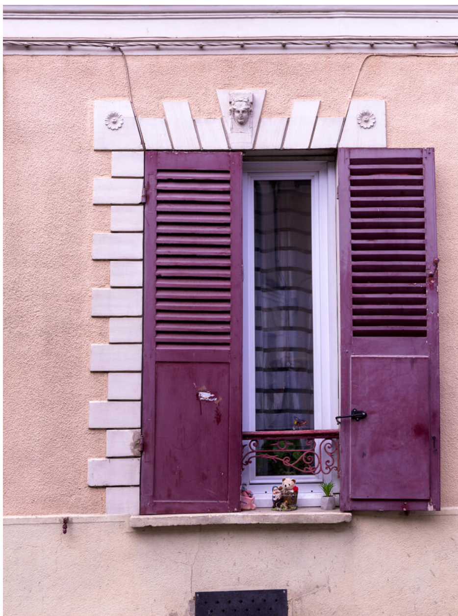
Vue de détail d'une baie du rez-de-chaussée.
