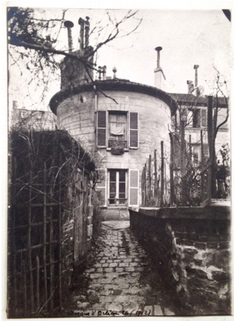
Vue du moulin transformé en habitation. Fonds d'archives de la Commission du Vieux Paris.
