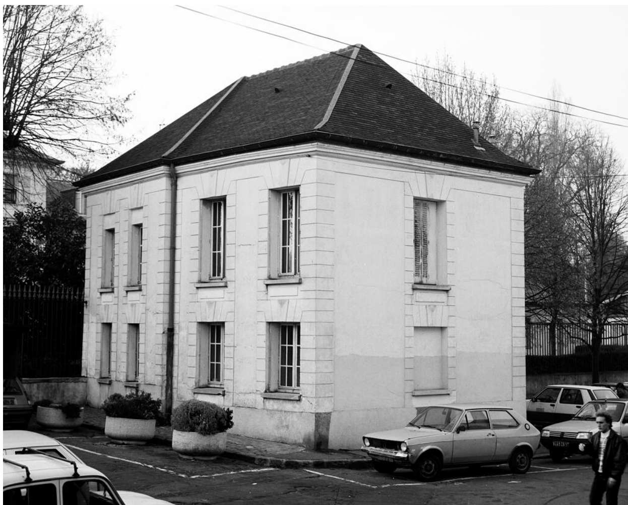
Pavillon d'entrée sur la place Voltaire.
