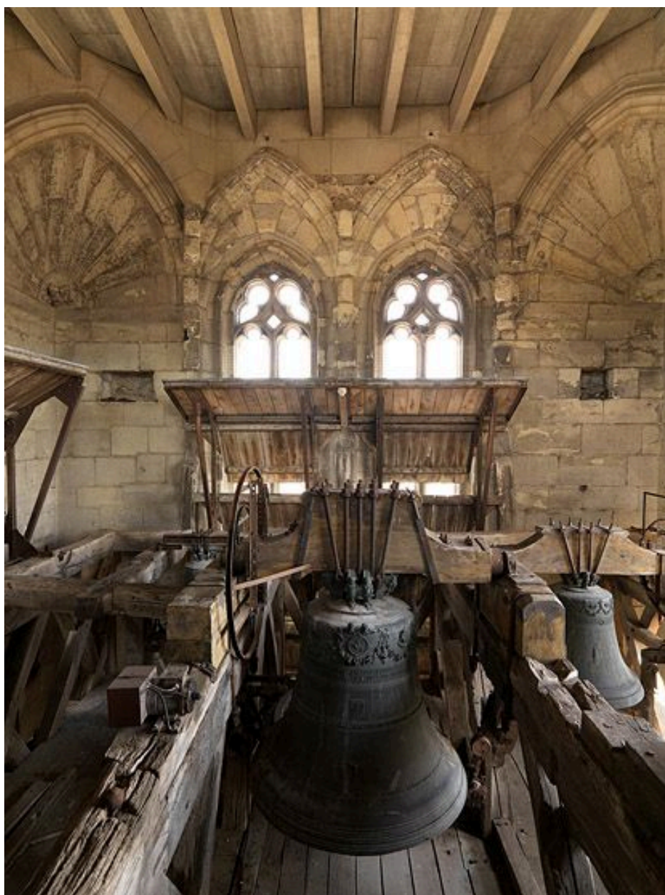
Tour nord, 3eme étage : vue intérieure du niveau des cloches.
