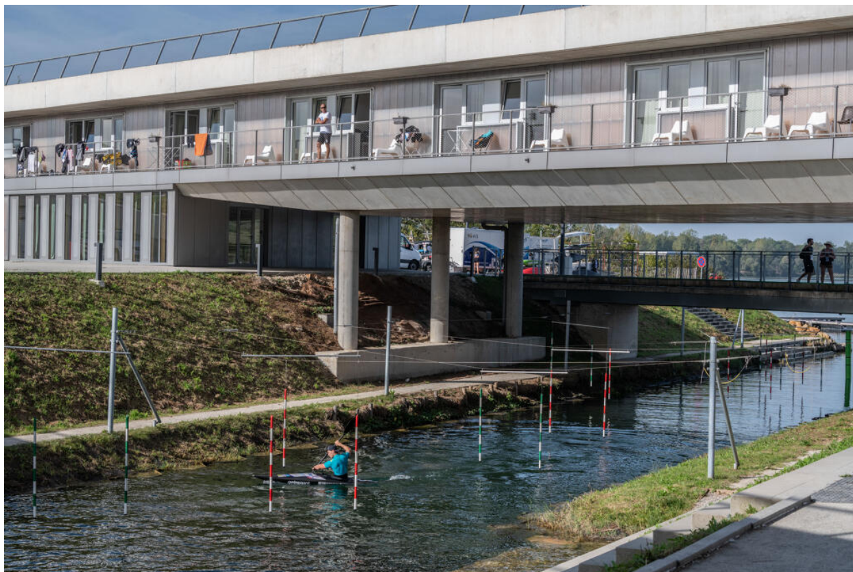
Stade nautique olympique. Vue sur les chambres aménagées en passerelle sur la rivière de compétition.
