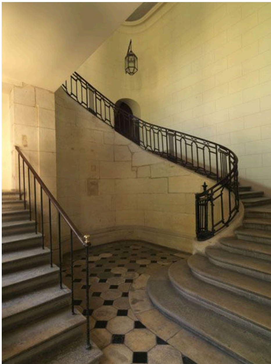
Vue d'ensemble de l'escalier.
