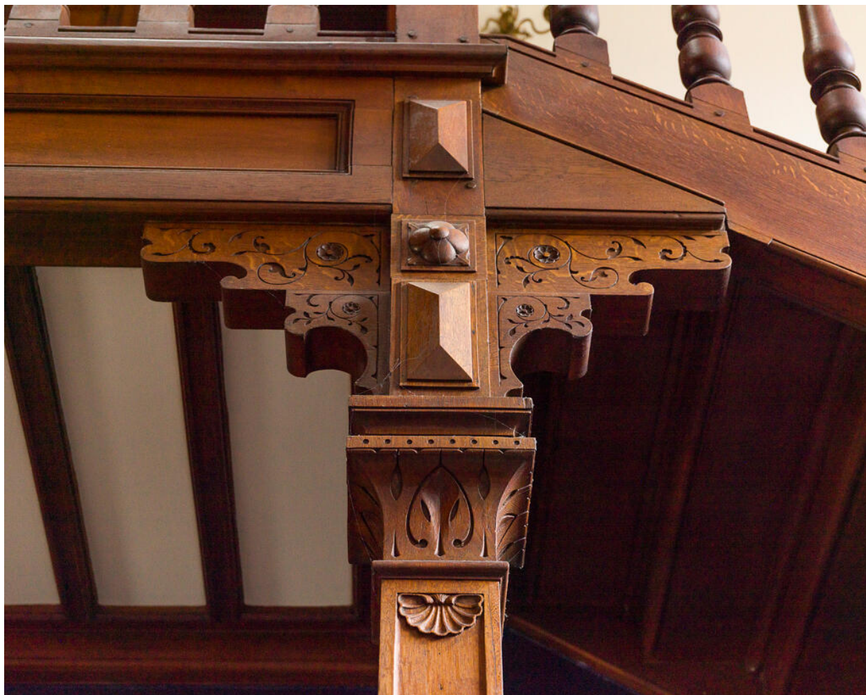
Assemblage de colonne de la cursive, au rez-de-chaussée.
