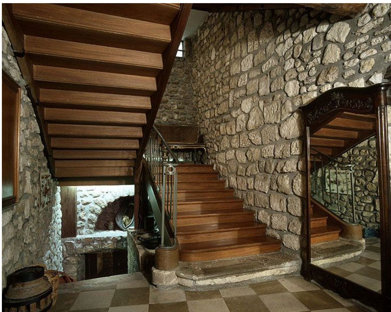
Vue de l'escalier.
