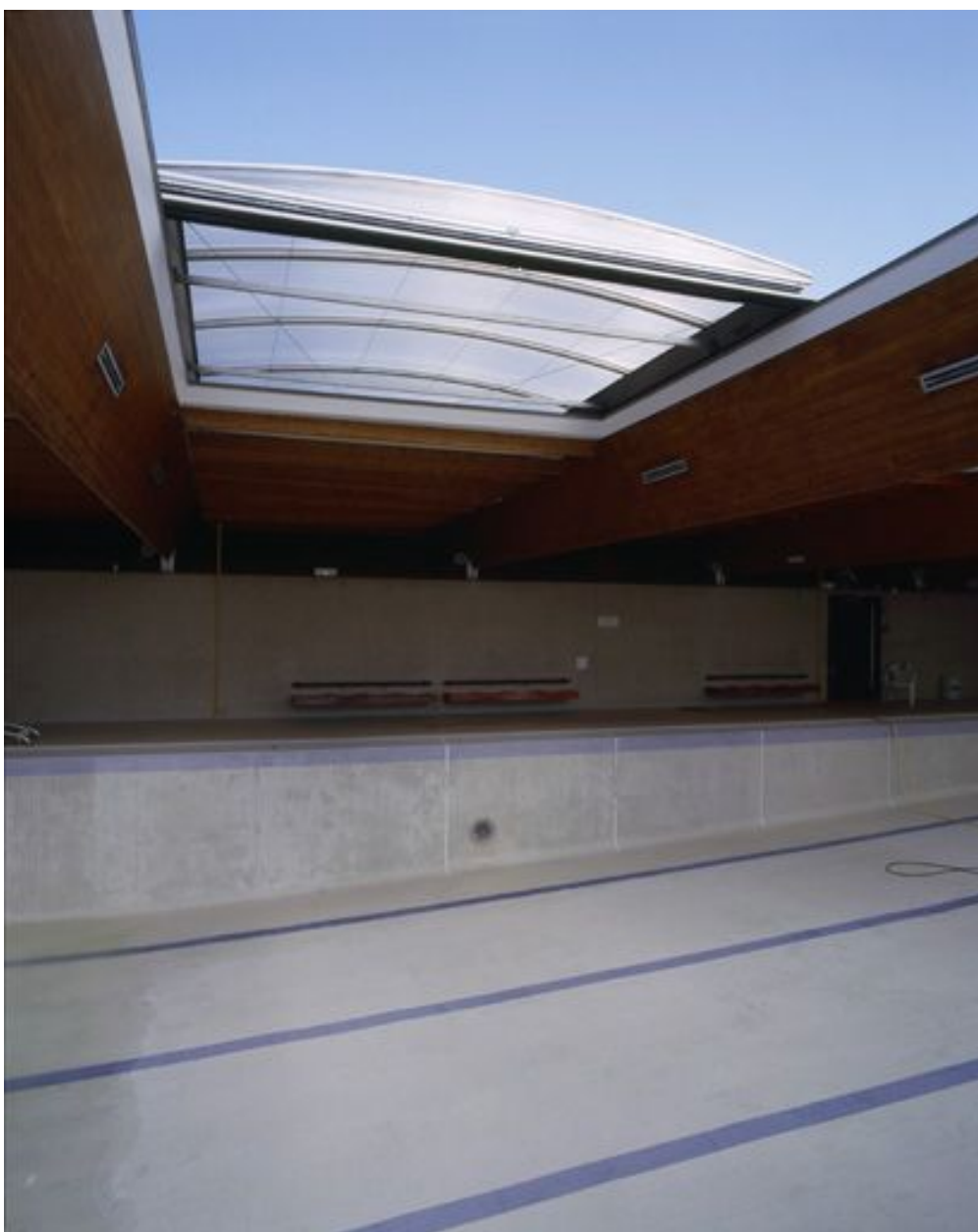
Vue intérieure : élément de toiture mobile ouvrant sur le bassin.
