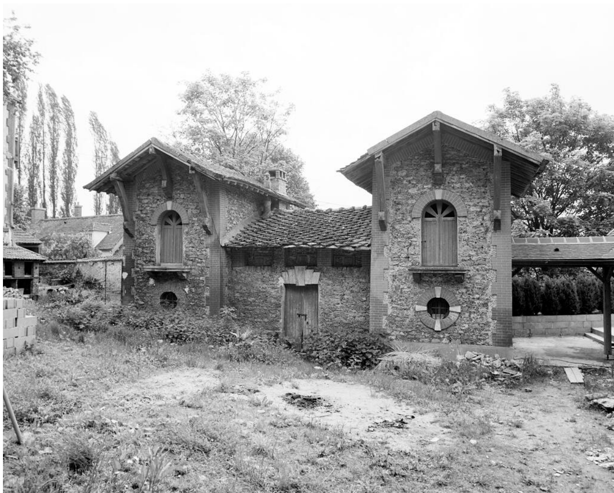
Façade antérieure de la bergerie.
