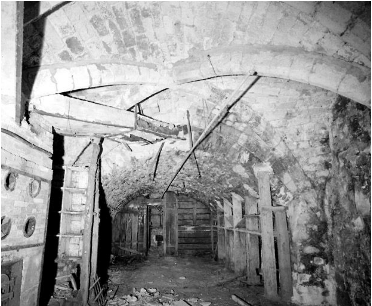
La cave du 18-20, rue Paul-Doumer : vue depuis l'ouest.
