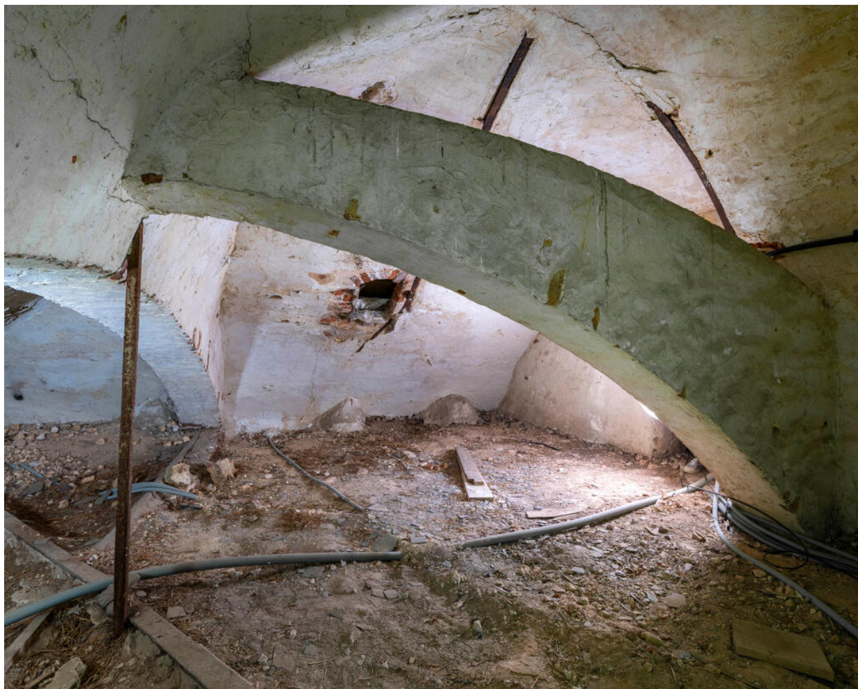
Charpente en maçonnerie de moellon et brique.
