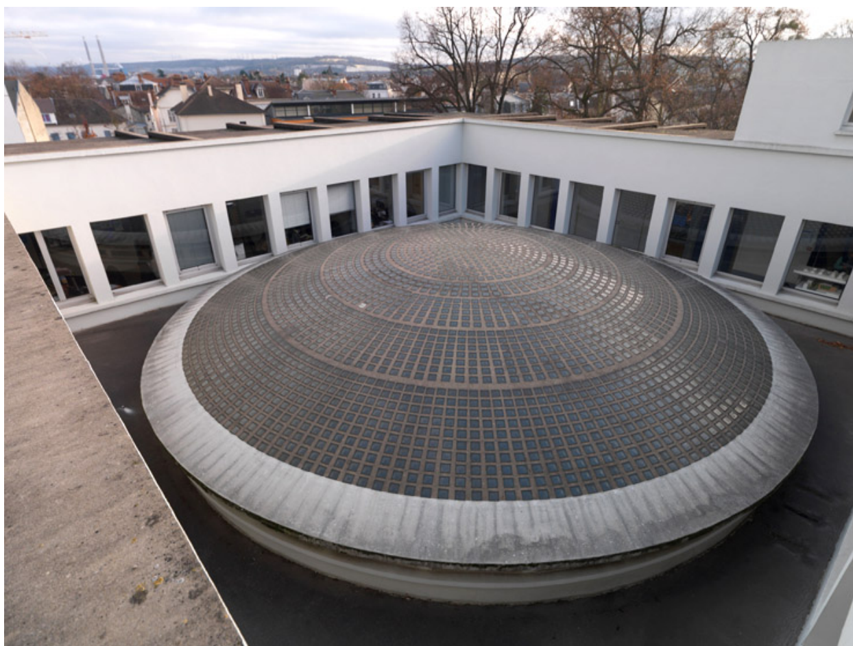
Vue de l'extrados de la coupole en dalle de verre.
