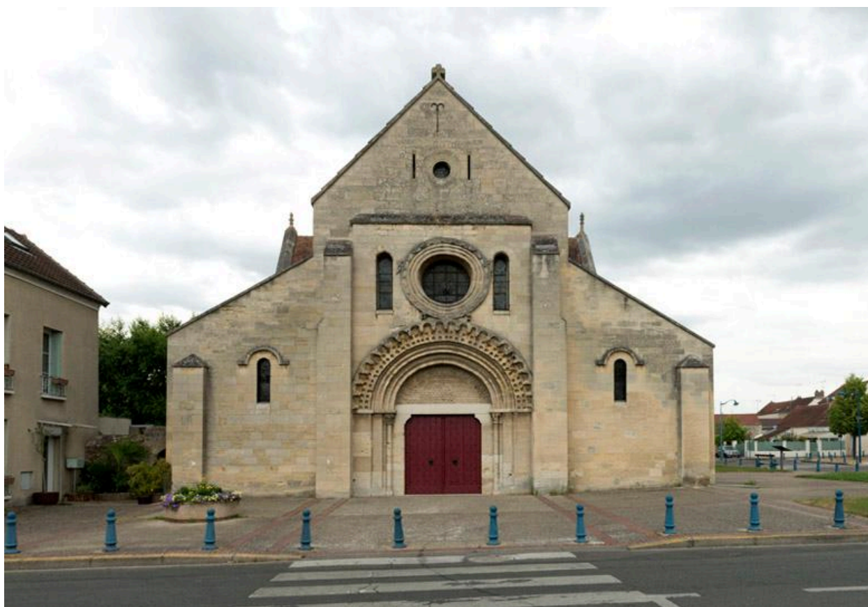
Vue de la façade occidentale.
