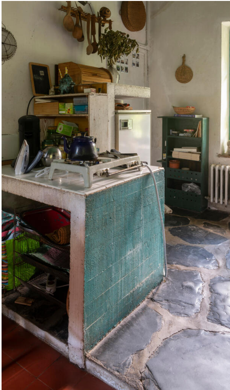
La cuisine aménagée par Manessier. Meubles et étagères intégrés en béton banché.
