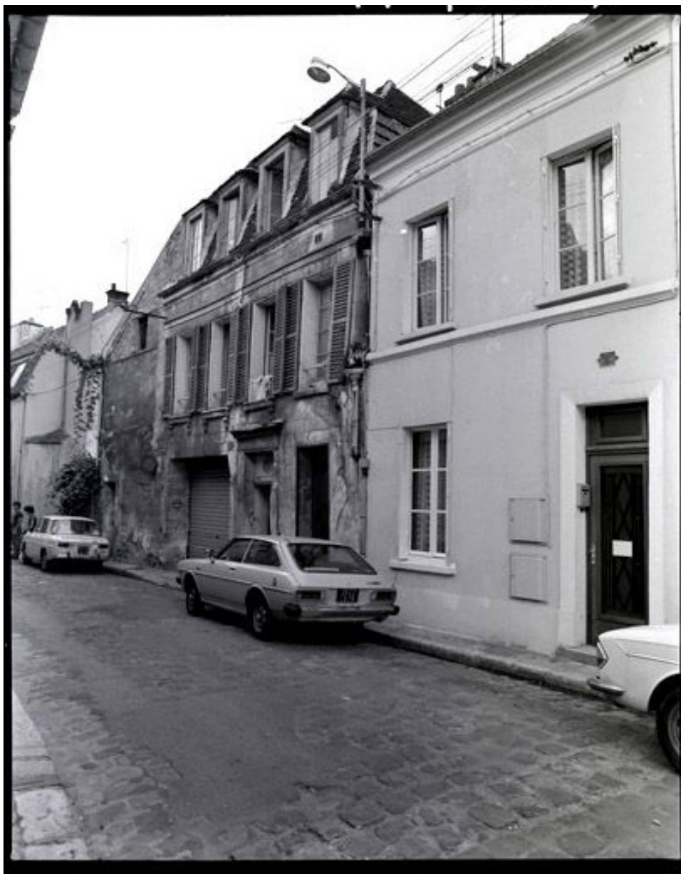
Maison, Tellerie (rue) 3. Façade principale sur rue.
